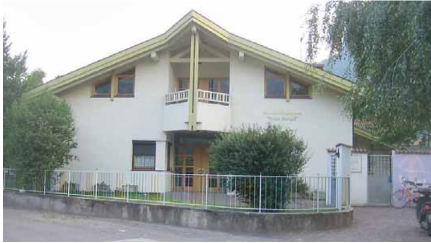
La scuola materna di lingua tedesca che verrà ristrutturata (Foto bt)
