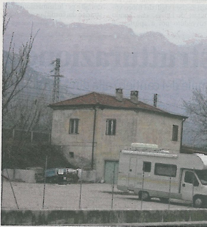
Uno skatepark nell'area dell'ex casello ferroviario
