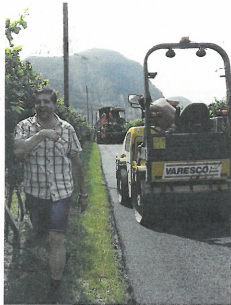
Arbeiten am Moosweg
