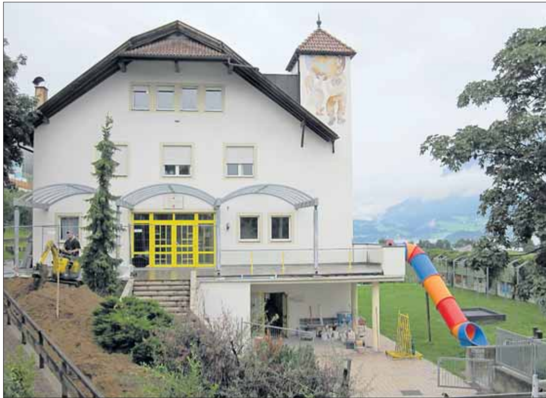
An der Unterinner Volksschule werden derzeit Umbauarbeiten durchgeführt.
