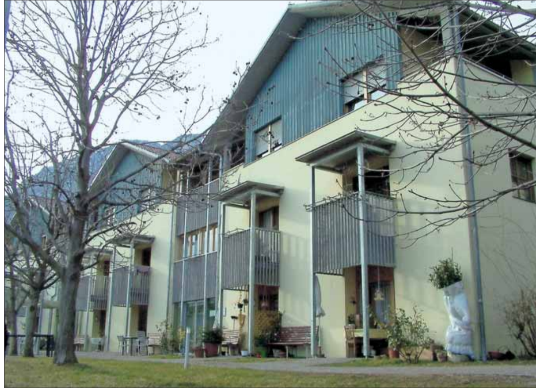
Für den Ausbau des Pflegeheims muss ein Investitionsprogramm erstellt werden.
