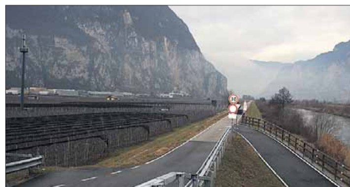
Der neue Gefahrenzonenplan der Gemeinde Salurn sieht die Verstärkung des Etschdammes südlich der Etschbrücke bis zur Landesgrenze vor. rd
