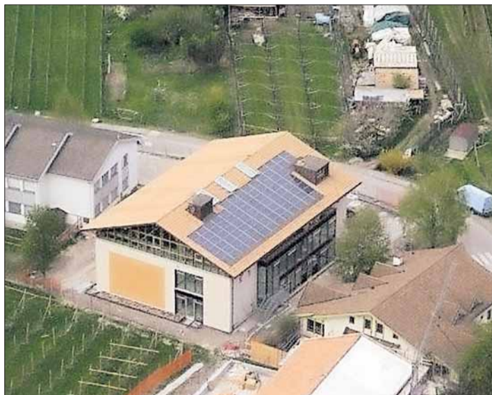
Im Bild die Photovoltaikanlage auf dem Dach des Hauses Curtinie.
